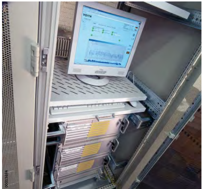
Figura 10 Condition Monitoring basado en el estado con el FAG VibroCheck
